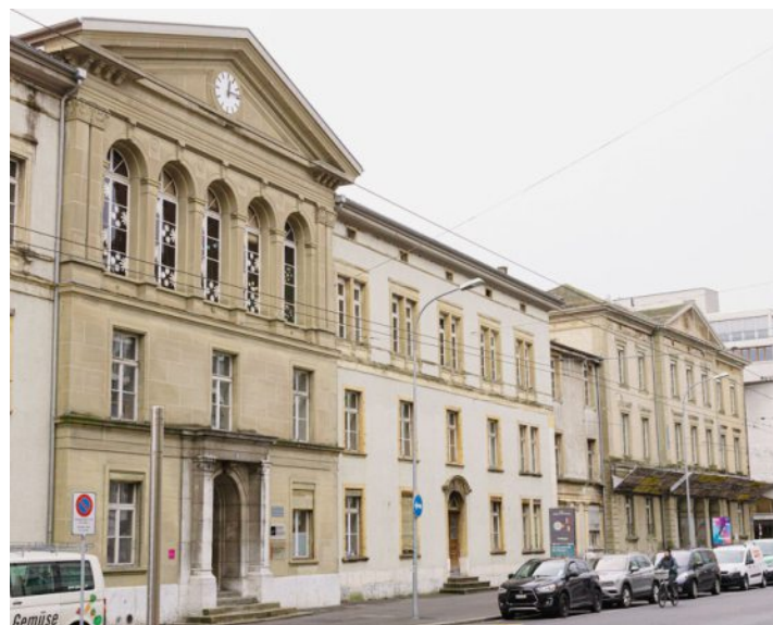
L'école Dufour, quelques semaines avant le début des travaux. JDJ
